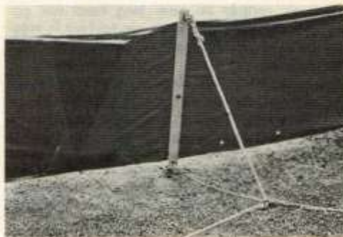
Foto 3: Hier ziet men een deel van het scherm op de wal. Links van de houten lat, waaraan de staglijnen worden vastgemaakt, bevindt zich een in de kunststof gelaste zak, waarin een zakje zand als ballast en een drijver. Hierdoor blijft het scherm onder alle omstandigheden in het water staan.
