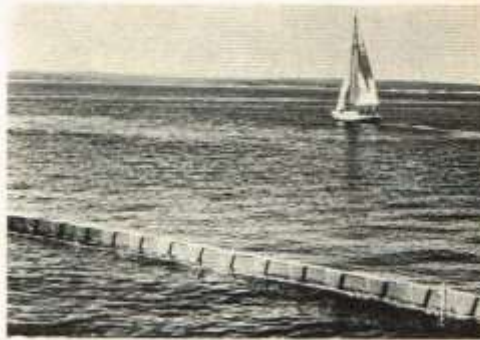
Foto 2: Deze foto toont een scherm, dat reeds in een haveningang is aangebracht. De zeilboot vaart door het „schone“ water de haven uit, terwijl op de voorgrond duidelijk te zien is, hoe het door olie zwart gekleurde water wordt tegengehouden door het scherm.
