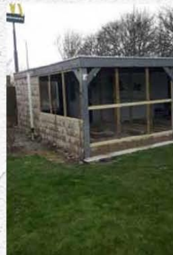
Frame van houten profielen 7 x 4,9 cm geïmpregneerd hout.
