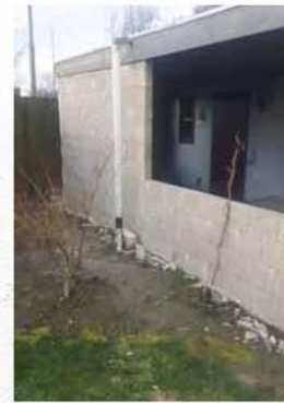
Wanden zijn dus opgetrokken met betonsteen 30x20x10 (cm)
